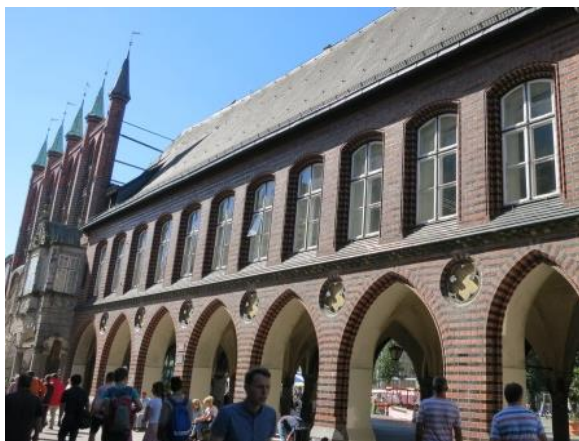
Abb. 26: Rathaus, Gebäudeteil A „Langes Haus“
