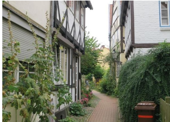
Abb. 29: Durchgang – Strukturprägender Gang und Hof
